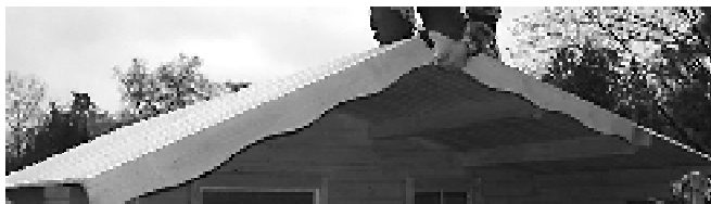
Přibíjení štítového prkna
