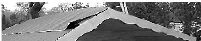
Překrytí hřebene lepenkou
